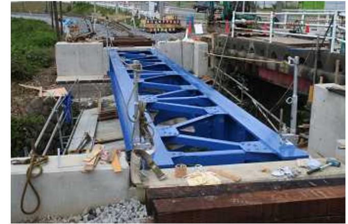
西六石川橋梁改修工事(2007.8.23)
