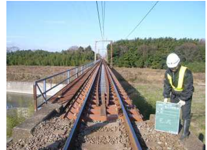
青川橋梁枕木交換工事(2007.12.28)
